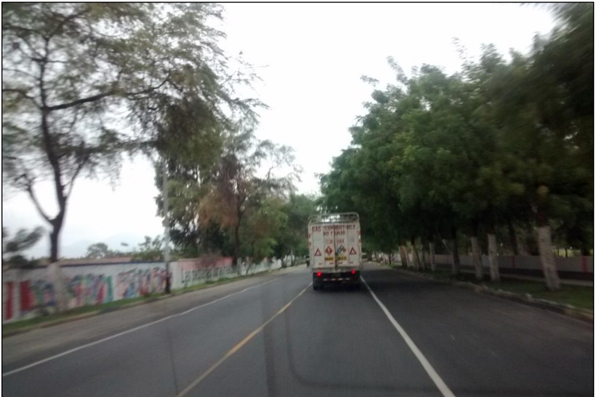
FOTO N° 04. Vista de la carretera PI 108, Prog. KM 7+100 donde se aprecia la señalización horizontal y la reconfiguración de bermas con aplicación de slurry Tipo III
