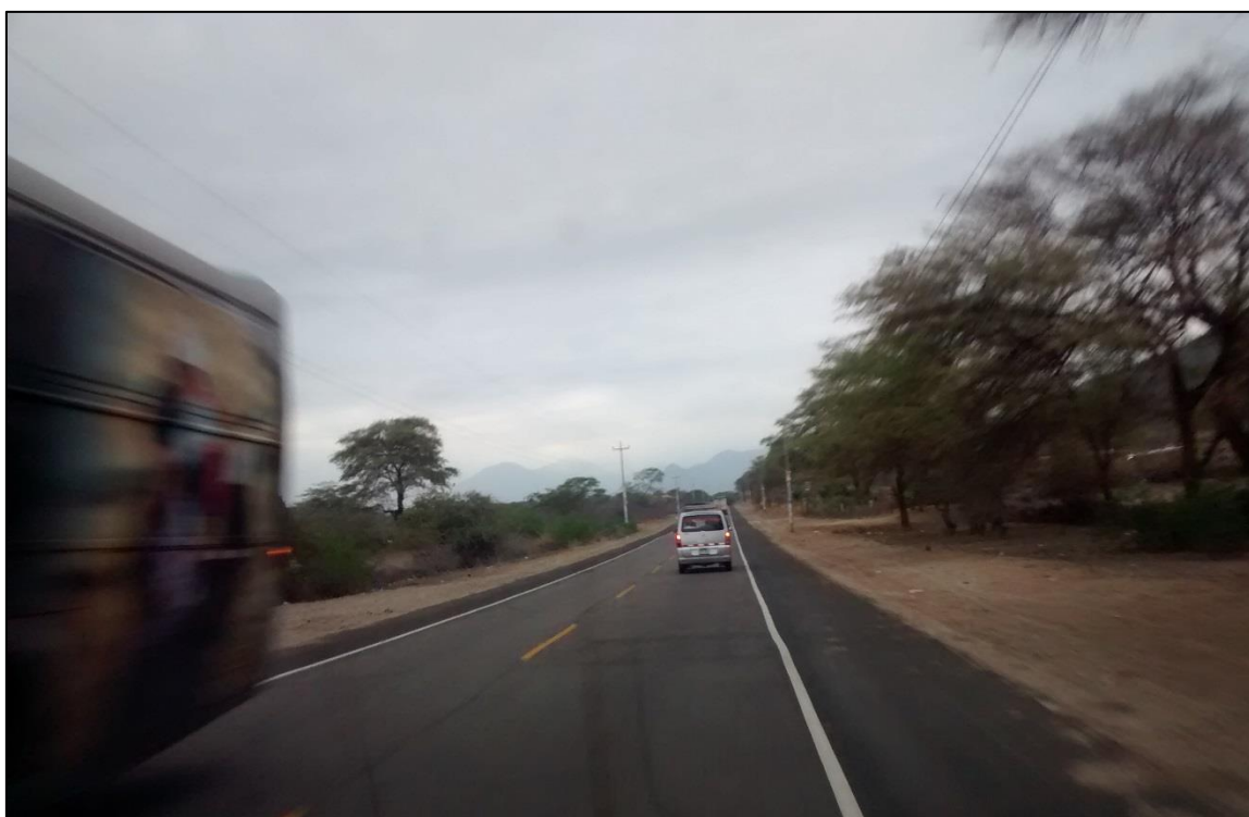
FOTO N° 02. Vista de la carretera PI 108, Prog. KM 2+100 donde se aprecia la señalización horizontal y la reconfiguración de bermas con aplicación de slurry Tipo III
