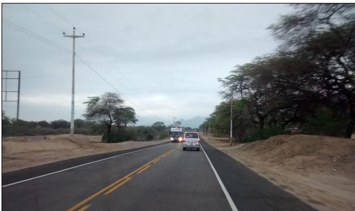
FOTO N° 01. Vista de la carretera PI 108, Prog. KM 1+200 donde se aprecia la señalización horizontal y la reconfiguración de bermas con aplicación de slurry Tipo III
