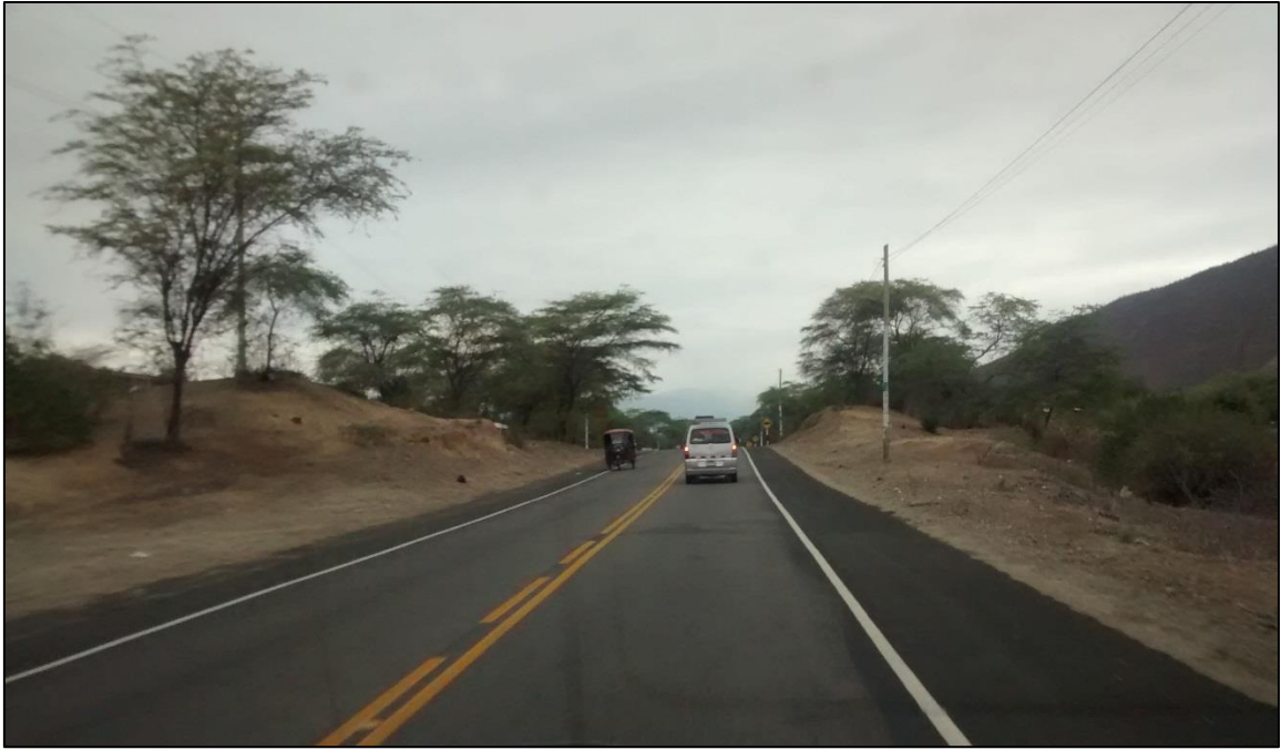
FOTO N° 03. Vista de la carretera PI 108, Prog. KM 3+900 donde se aprecia la señalización horizontal y la reconfiguración de bermas con aplicación de slurry Tipo III
