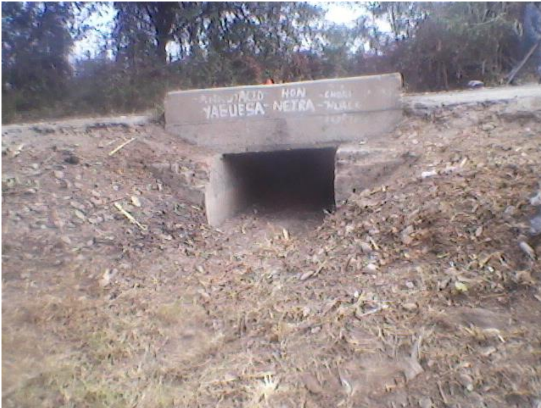
Foto N° 1: Se observa la limpieza de alcantarilla.
